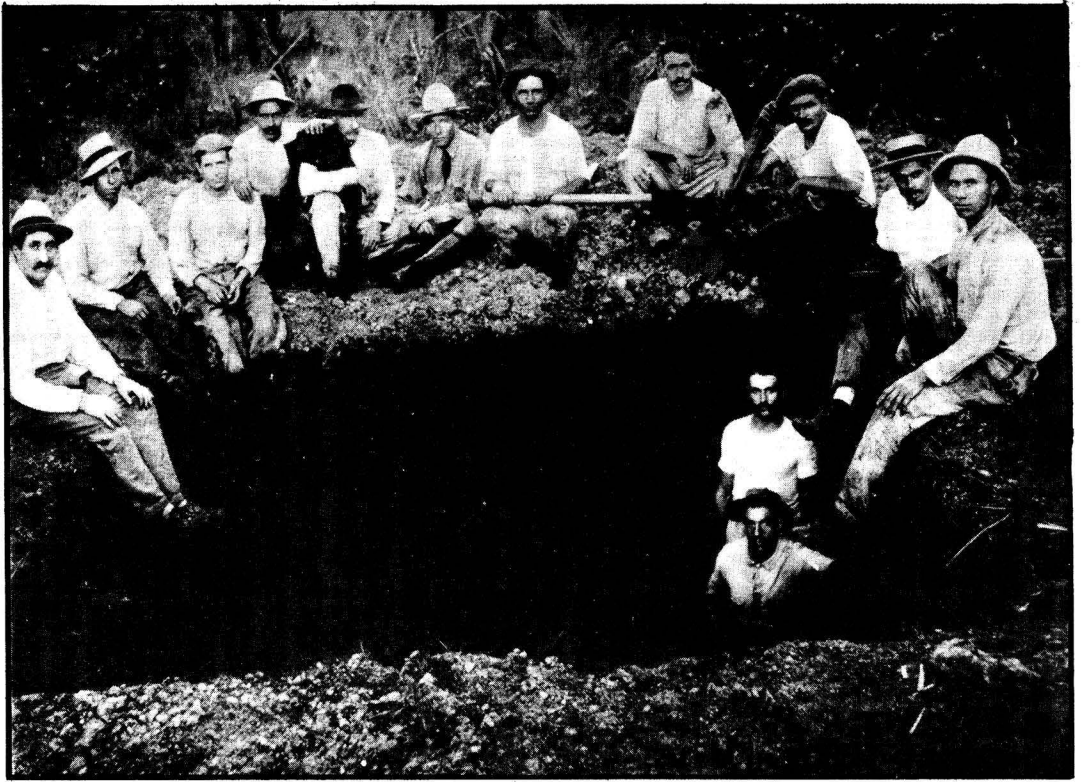
El señor Abel DEL RIO y trabajadores en una excavación para el emplazamiento de bombas.
